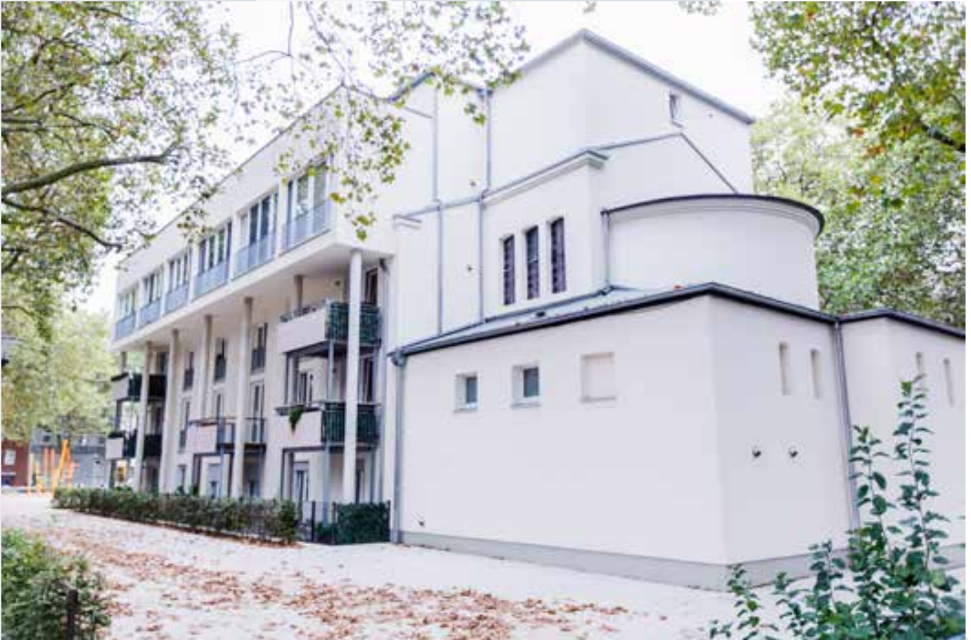
Aus der katholischen Kirche St. Norbertus am Blumenplatz in der Weststadt wurde ein Wohnhaus mit 22 Sozialwohnungen..
