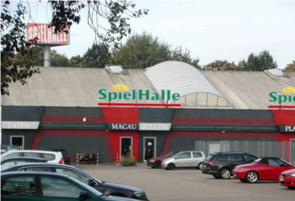
Abb. 15: Spielhalle im Gewerbegebiet Bruchfeld
